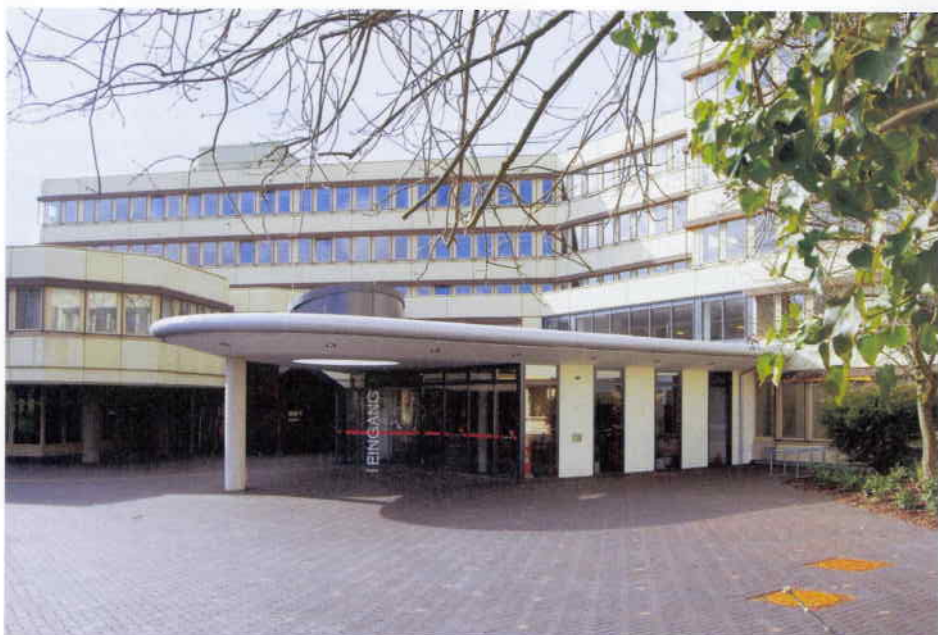
Kreishaus in Detmold: Das vom Kreis Lippe gewählte Modell für die Bewirtschaftung der Straßen ermöglicht, Geld zu sparen und die Qualität des Straßennetzes zu sichern.
