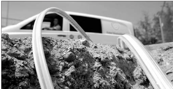
Kurz vor der Montage in der Baugrube: Leerrohre zur Verlegung von Glasfaserkabel.
