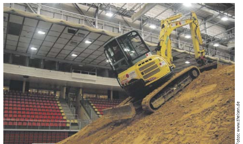
Der Yanmar ViO 50 von Theisen ist nur eine der für den Aufbau der Bahnen erforderlichen Baumaschinen.
