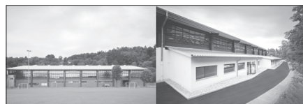
In den kommenden Wochen erfolgt die Verkabelung und Installation des öffentlichen Zuschauerbereichs des Deggendorfer Eisstadions mit WLAN.
